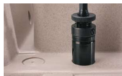
C - Procedere con il completamento del foro
